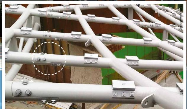
Die Stoßverbindungen der Hohlprofile mit rundem Querschnitt wurden mit Hollo-Bolt hergestellt
