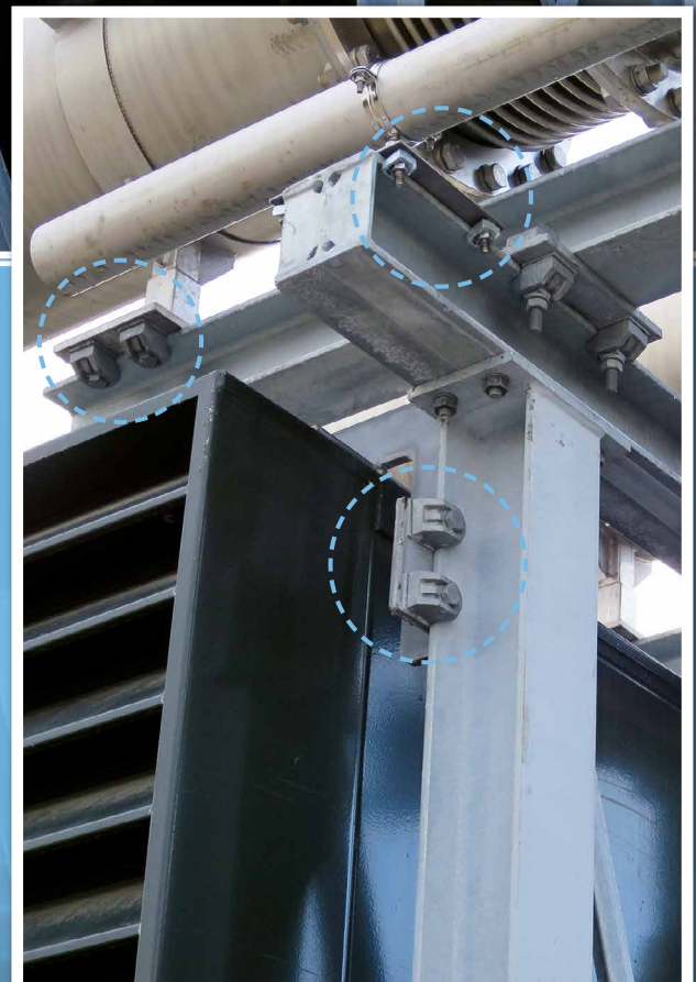
Les crapauds de fixation utilisés pour résister aux efforts de traction et de glissement
