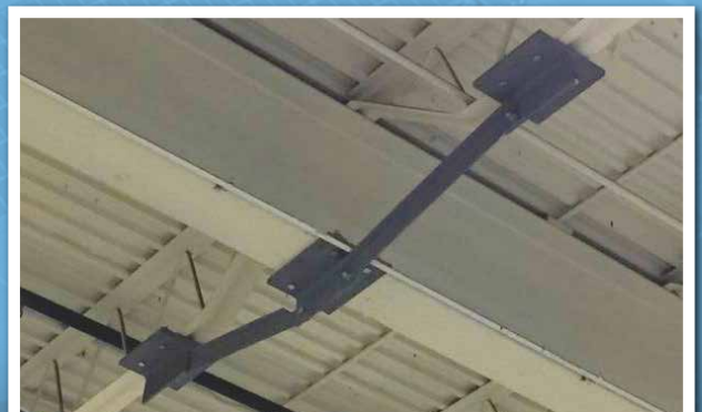
Die Verstrebungen wurden mit Trägerklemmen Typ AF montiert
