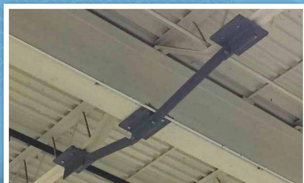
Les crapauds de fixation Type AF relient le support de renforcement
