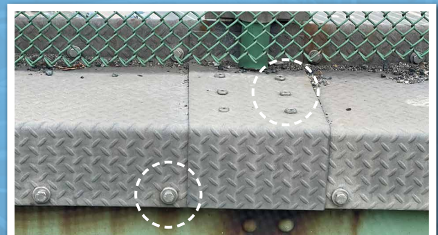
Der Hollo-Bolt bot eine Lösung für Reparaturen am Unterbau und die Modernisierung der Sicherheitswege.
