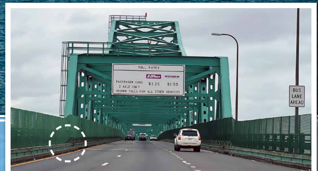
Die Brücke musste modernisiert werden, um den Verkehrsfluss zu verbessern und Arbeitsbereiche abzusichern.
