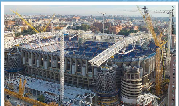
Während der gesamten Renovierungsdauer fanden im Stadion Spiele statt
