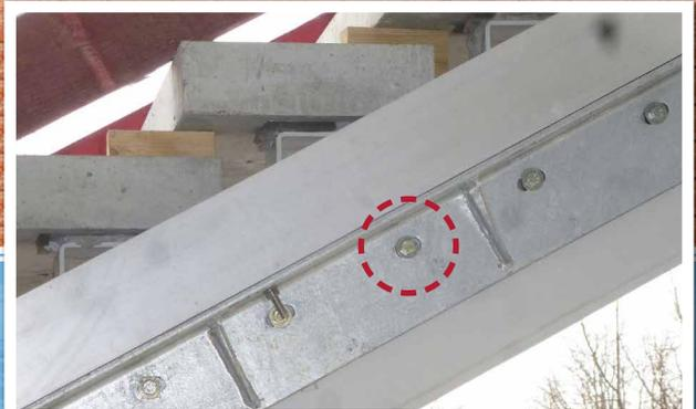
Das L-Profil wird mit Hollo-Bolt an den Stahlbau-Hohlprofilen montiert
