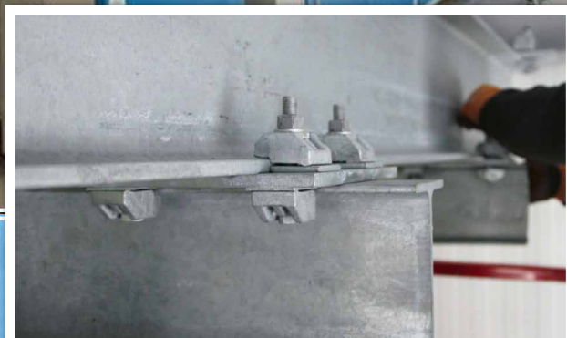
Les crapauds de fixation Type AF utilisés pour relier les poutres
