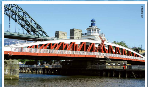
Die Newcastle Swing Bridge nach der Instandsetzung
