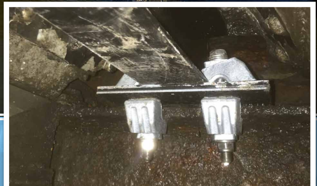
Die Träger der Verstrebung wurden mit Typ AAF montiert
