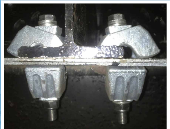
Durch die Verwendung von Trägerklemmen war die Verbindung bohr- und schweißfrei
