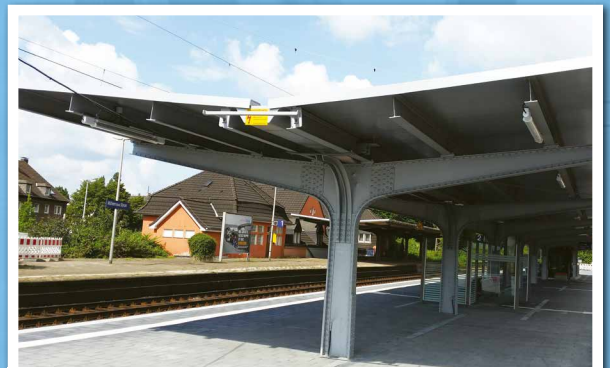
Bahnsteig nach der Sanierung
