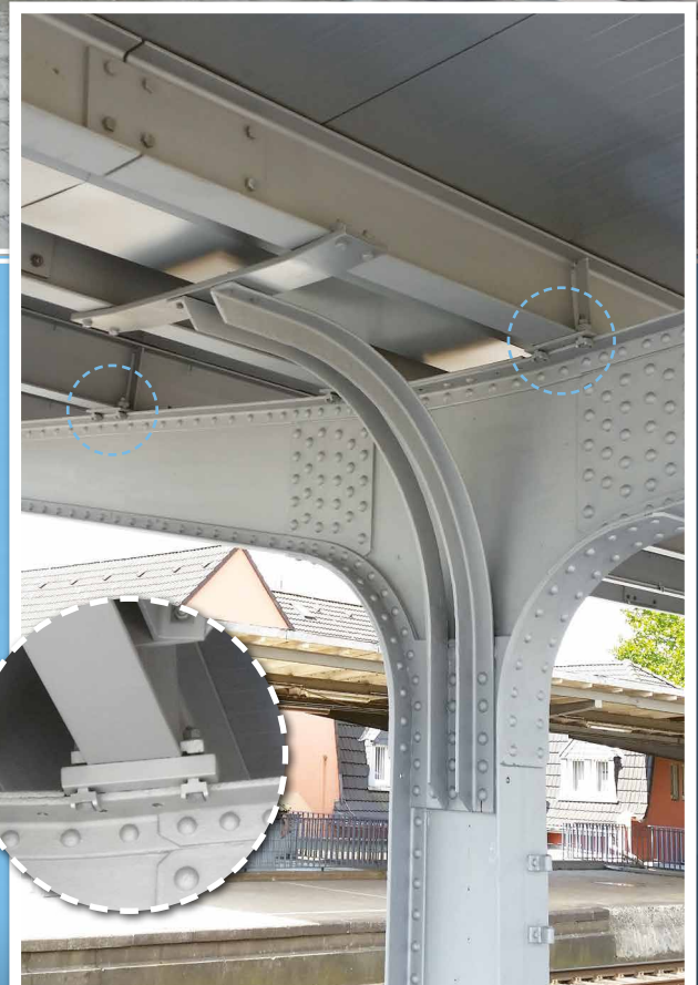
An die Stützen montierte Stahlträger
