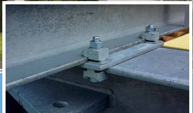
Die Stahlkonstruktion wurde mit Trägerklemmen montiert
