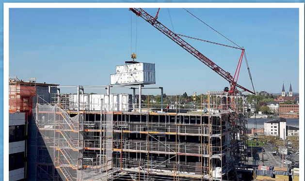
Installation der Klimageräte
