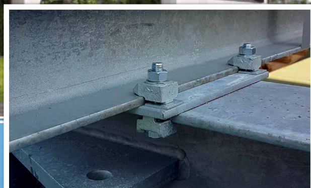
La charpente métallique est fixée à l'aide de crapauds d'assemblage de poutre
