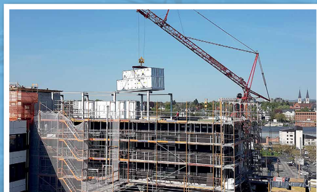
Installation des appareils de climatisation
