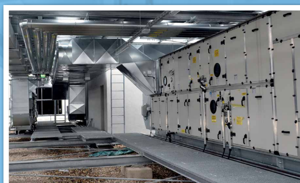
L'étage supplémentaire est créé par des poutres métalliques
