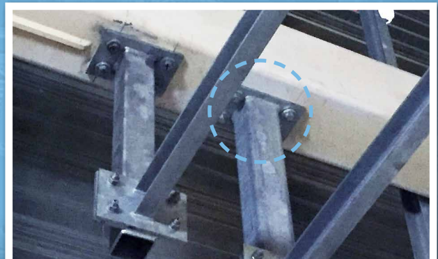
Die Rohrhalterungen wurden mit Hollo-Bolt montiert
