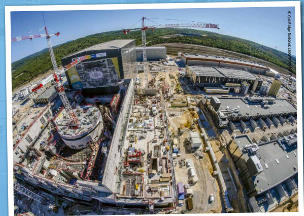
Der ITER-Kernfusionsreaktor im Bau
