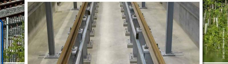
Die Schienen wurden mit Schienenklemmen Typ HD befestigt
