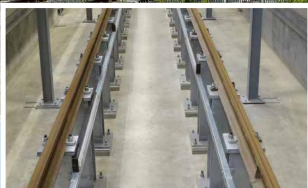
Les crapauds Type HD utilisés pour sécuriser les rails
