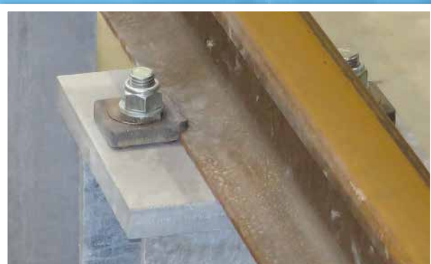
Les trains roulent sur les rails jusqu'à la zone d'assemblage
