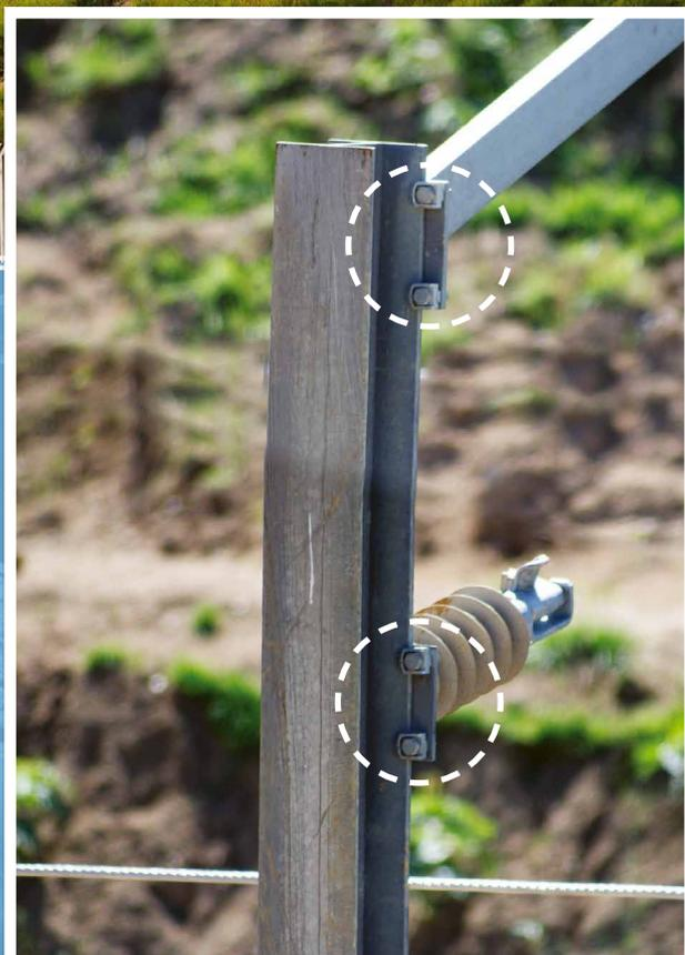
*Les pinces de type A ont permis de fixer des bras en porte-à-faux à des colonnes d'acier et des isolateurs d'équipement aérien à des poutres en I*
