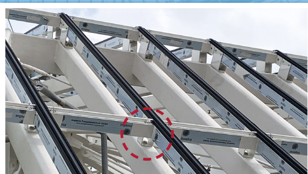
Nouveaux cadres de vitrage fixés aux supports en U
