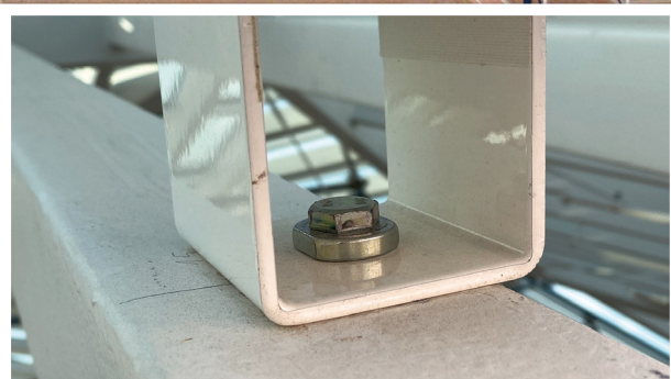
Hollo-Bolt utilisé pour assembler le support en U aux profilés creux existants
