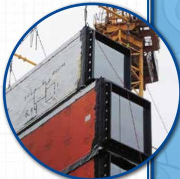
Anschließend wurden die Hohlprofile der Module durch die Schubplatten mit Hollo-Bolt mit Sechskantkopf und Hollo-Bolt mit Senkschraube miteinander verbunden.
