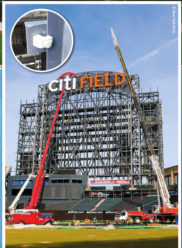
Typ AAF verbindet die Winkelhalterung mit den Stahlstützen
