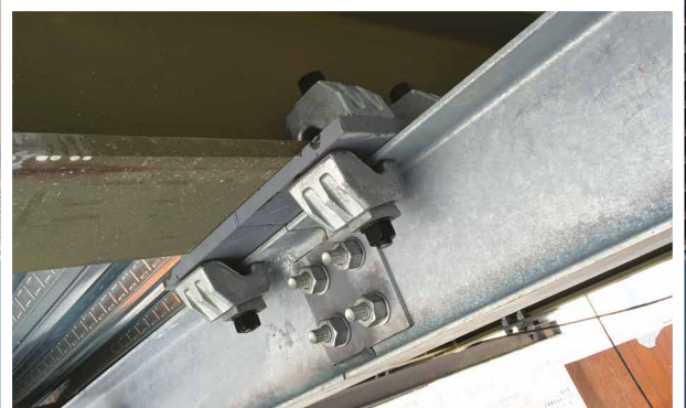
Trägerklemme Typ AAF in der Konfiguration mit 4 Schrauben
