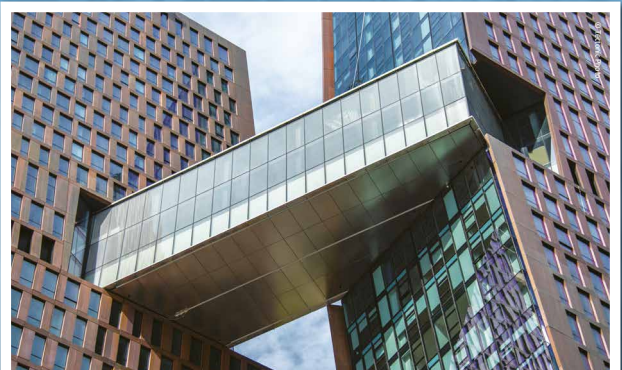
Eine dreigeschossige Skybridge verbindet die beiden Türme
