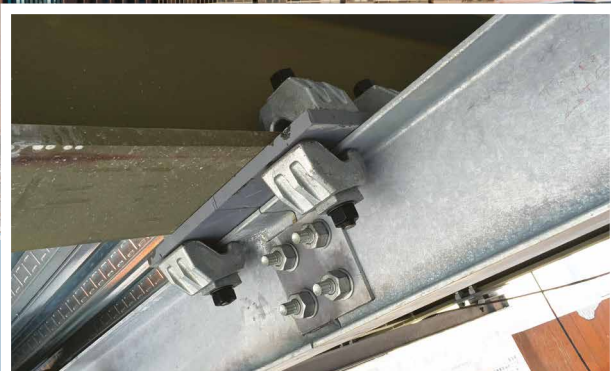
Crapauds de fixation Type AAF dans une configuration à quatre boulons
