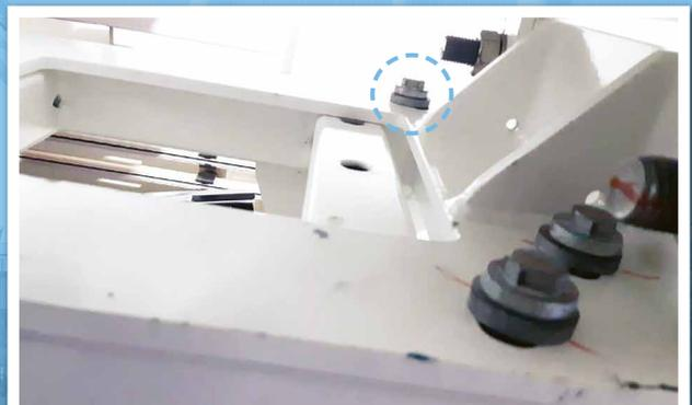
*Hollo-Bolt war schnell in die vorgebohrten Löcher eingesetzt*
